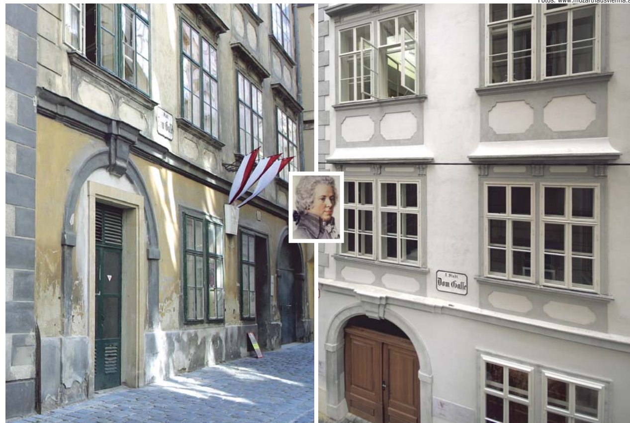
Das Mozarthaus in Wien, Domgasse 5: Vor und nach der Renovierung
